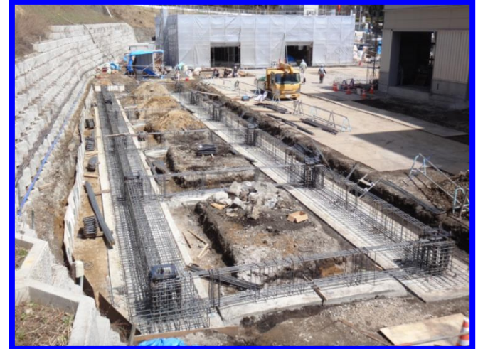
コンクリート工事
